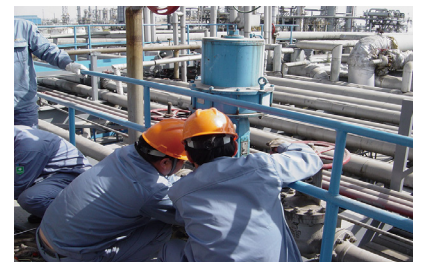
现场维护 Site maintenance
